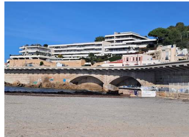
Anciennes fondations visibles depuis la plage du Prophète
